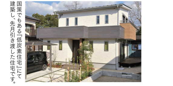
国策でもある「低炭素住宅」にて建築し、先月引き渡した住宅です。
